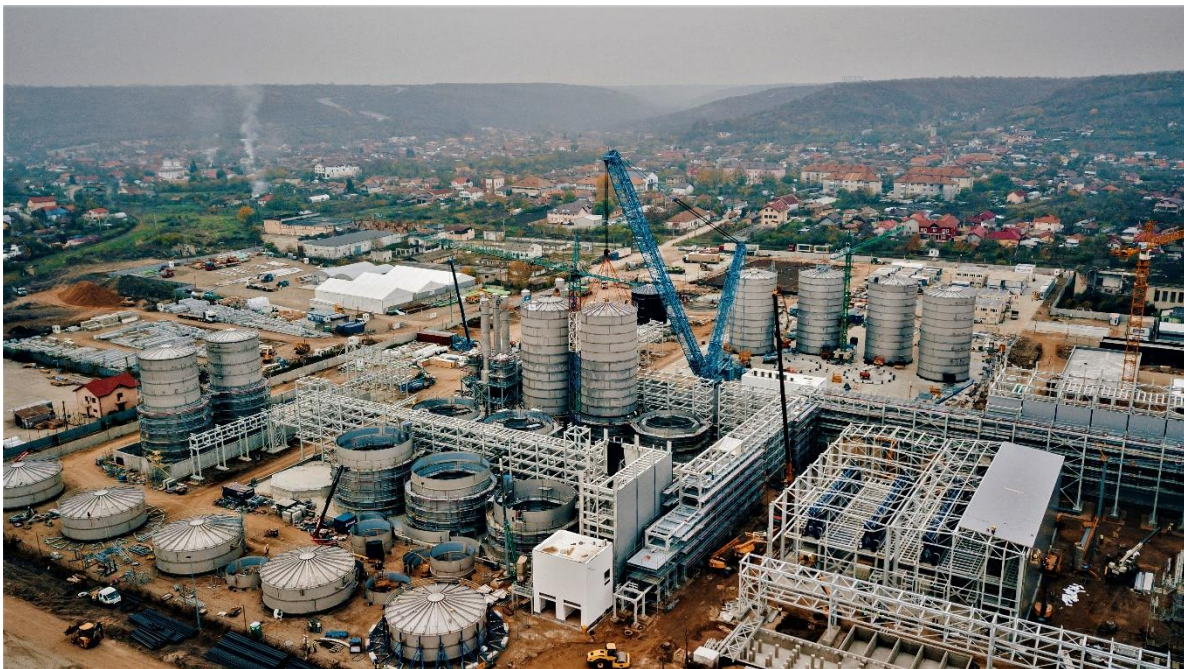
Luftaufnahme der Clariant sunliquid®-Baustelle in Podari, Rumänien, im November 2020 (Foto: Clariant)
